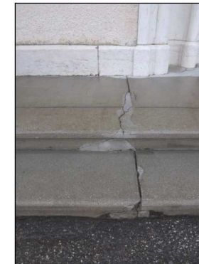
FISSURES AU NIVEAU DE L'EMMARCHEMENT DU PARVIS
