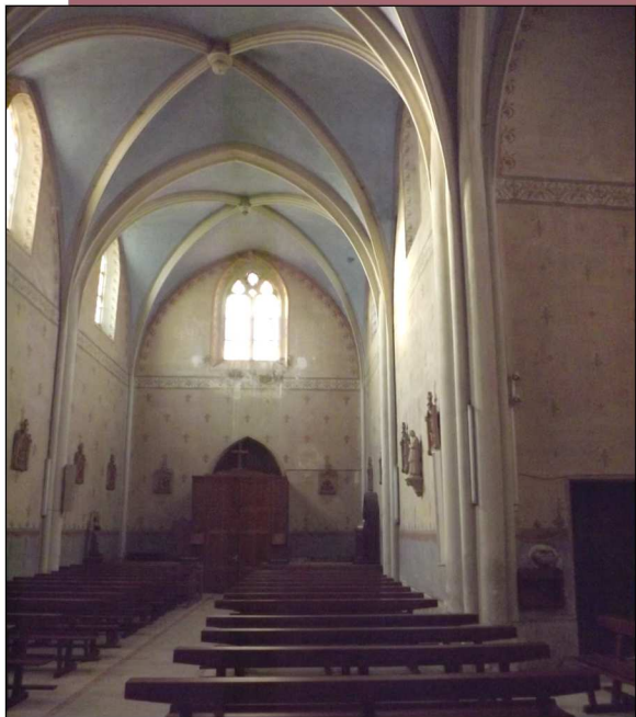
NEF - VUE SUR L'ENTREE
