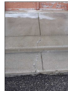
FISSURES AU NIVEAU DE L'EMMARCHEMENT DU PARVIS
