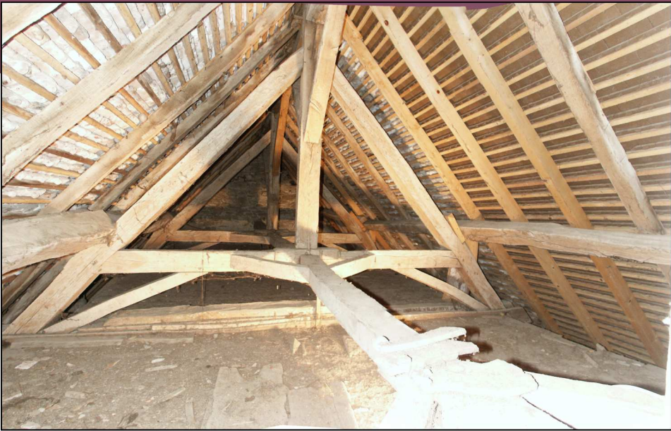
CHARPENTE DE LA NEF
