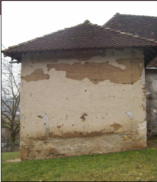
MUR EN PISE DE LA SACRISTIE (FACADE NORD)
