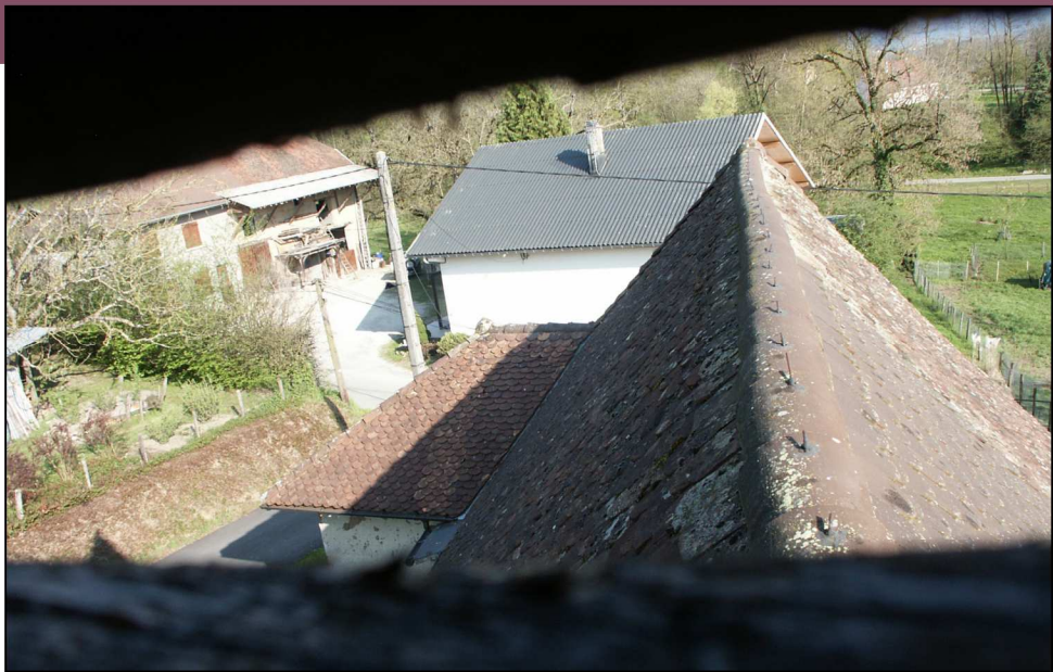
VUE DU FAITAGE (NEF)
