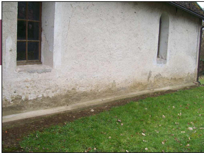
BORDURE CIMENT EN FACADE NORD
