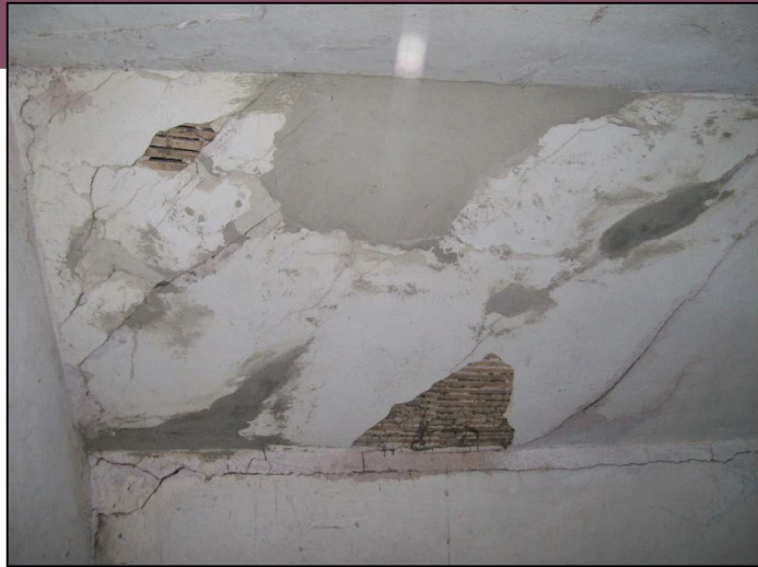
PLAFOND DE LA NEF (lattis/plâtre)
