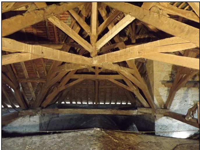
CHARPENTE AU DESSUS DE LA CROISEE DU TRANSEPT JONCTION AVEC LE CLOCHER
