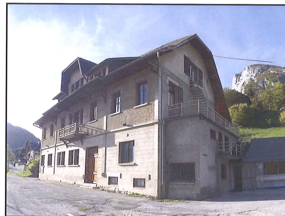
FACADES SUD ET EST
