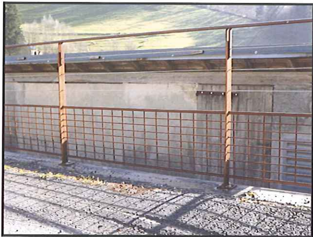
Garde corps métallique existant sur place, servant de modèle aux nouveaux gardes corps.
