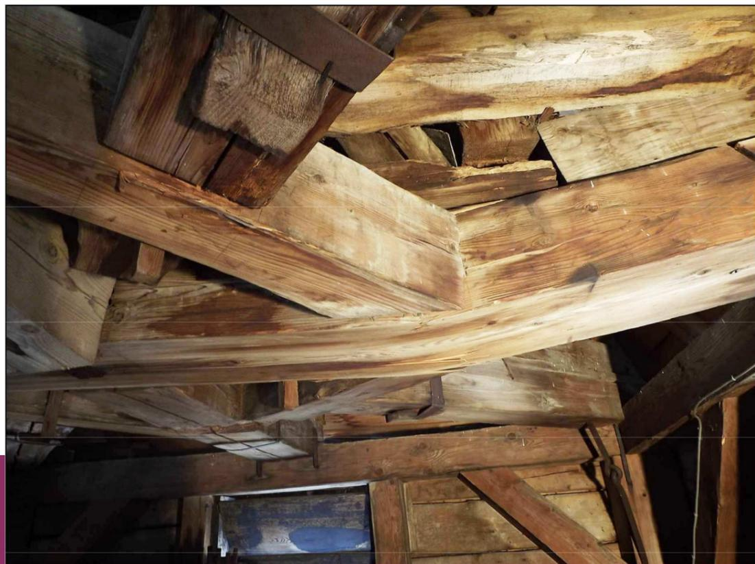
Consolidation du clocher par mise place d'un système d'étai en appui sur la charpente existante pour renforcement de la pièce cassée et reprise de celle-ci
