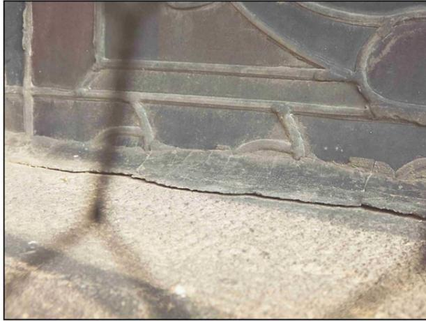
Étanchéité entre les vitraux et la maçonnerie à reprendre
